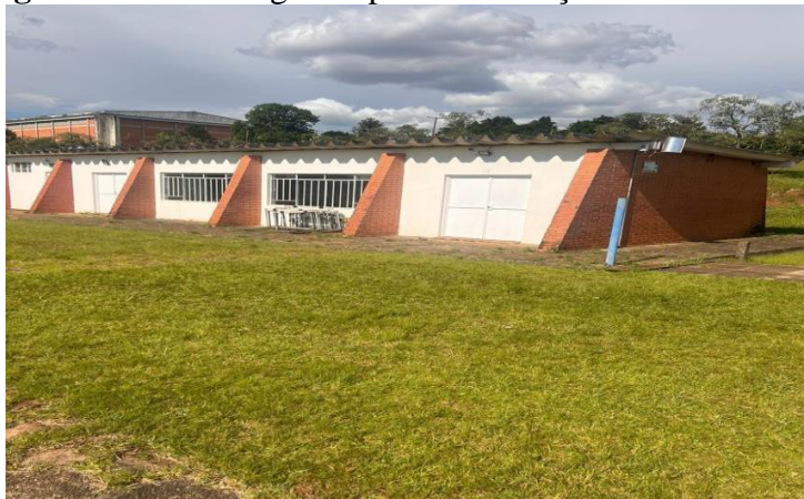
Figura 1 – Local cogitado para a instalação do ambulatório.
